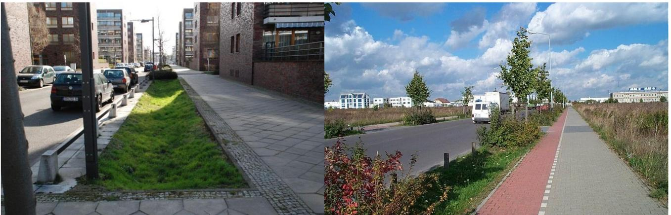
Abb. 1: Mulden-Rigolenversickerung zur Straßenentwässerung in einem innerstädtischen Wohngebiet und einem Gewerbegebiet [Fotos: IPS]
