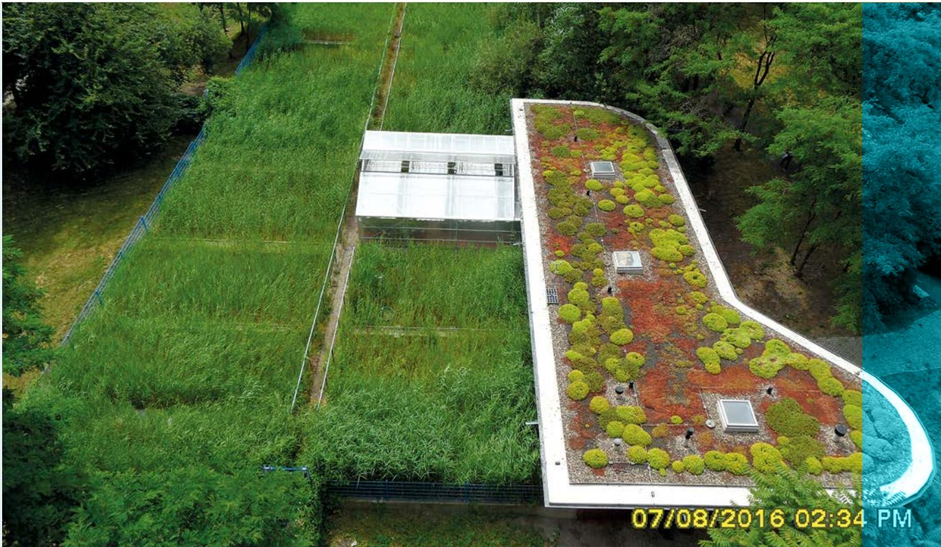
Abb. 1: Blick auf das „Besucherhaus“ im Block 6 von ROOF WATER-FARM. Es beheimatet die Grauwasserrecyclinganlage und eine Schwarzwasseranlage. Die Produkte Betriebs- und „Goldwasser“ werden im angrenzenden Gewächshaus getestet.
