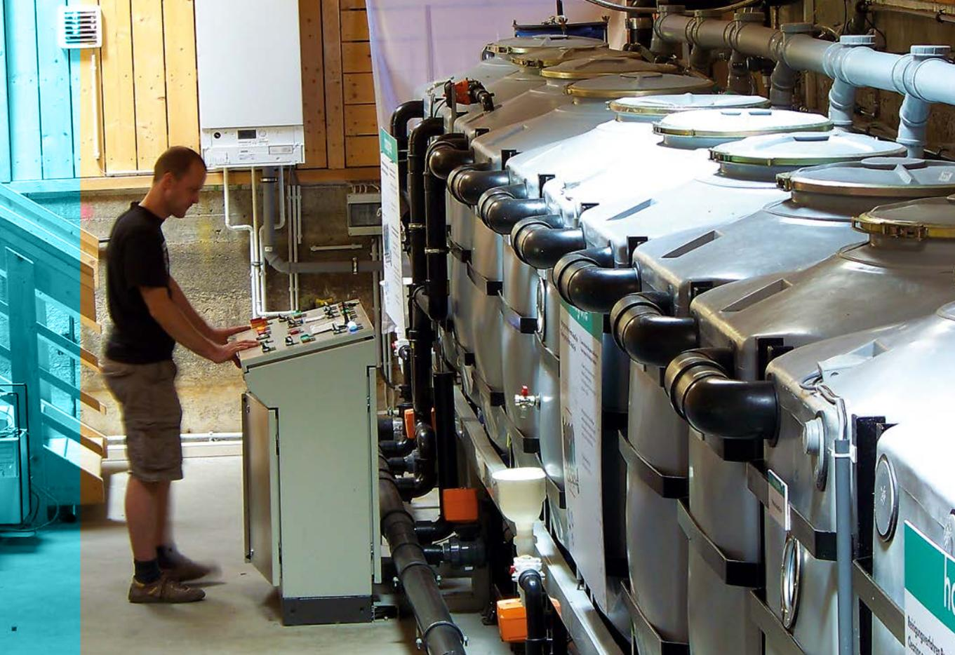
Abb. 3: Blick auf die mehrstufige Grauwasserrecyclinganlage im Block 6. Quelle: Nolde & Partner
