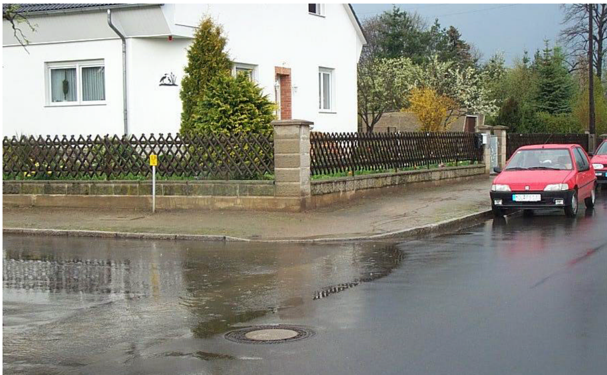
Abbildung 4: Oberflächliche Abflüsse in der Straße „Im Busch“ in Birkenstein
