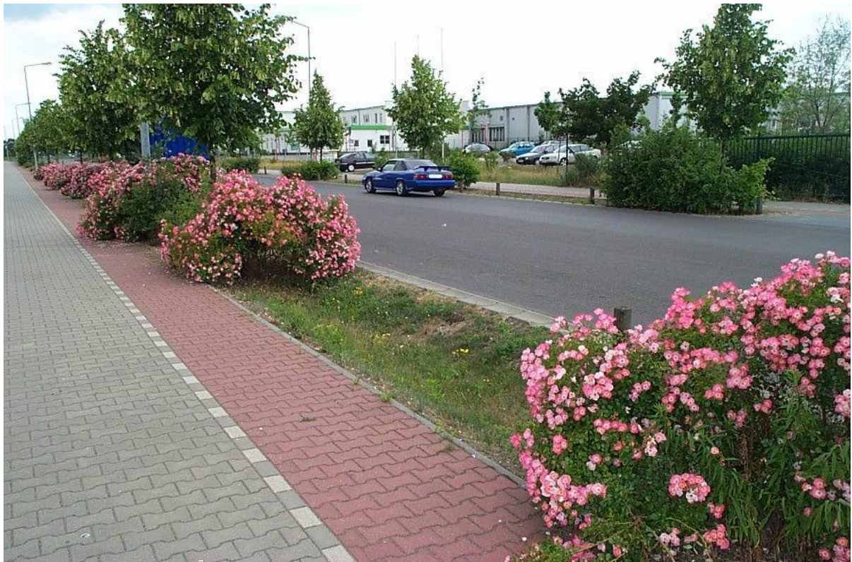
Abbildung 6: Mulden-Rigolen-System im Gewerbegebiet Hoppegarten
