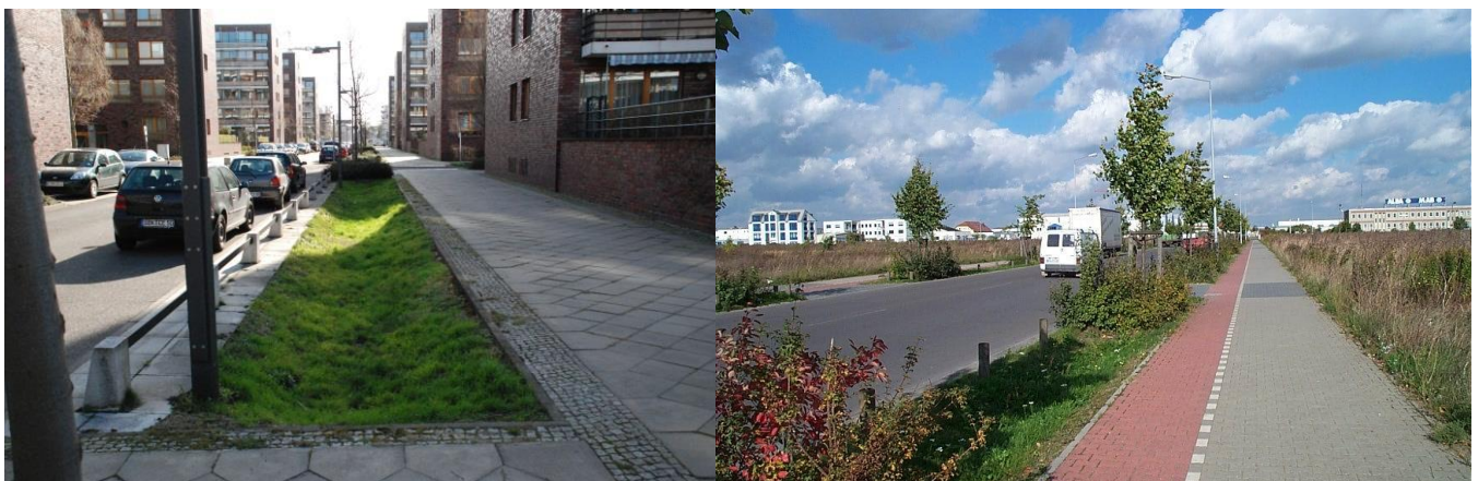
Abb. 1: Mulden-Rigolenversickerung zur Straßenentwässerung in einem innerstädtischen Wohngebiet und einem Gewerbegebiet [Fotos: IPS]
