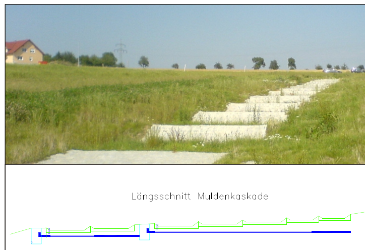
Muldenkaskade im Neubaubereich Döttinger Straße
